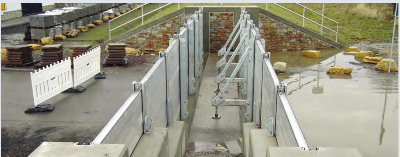
Hochwasserschutzmauer mit mobilem Aufsatz und Wegedurchlass
