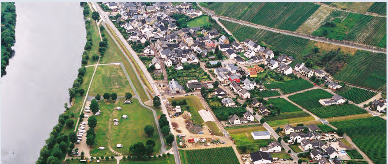
Hochwasserschutzanlage Kesten/Mosel, Übersicht
