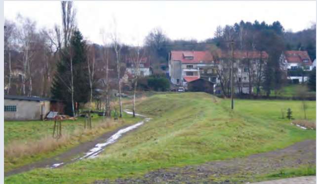
Hochwasserschutzdeich an der Blies in Ottweiler
