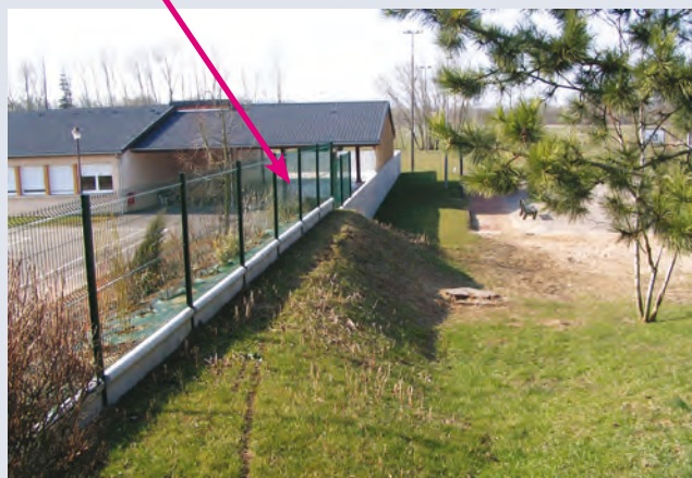
Hochwasserschutzmaßnahme bei Argancy an der Mosel
