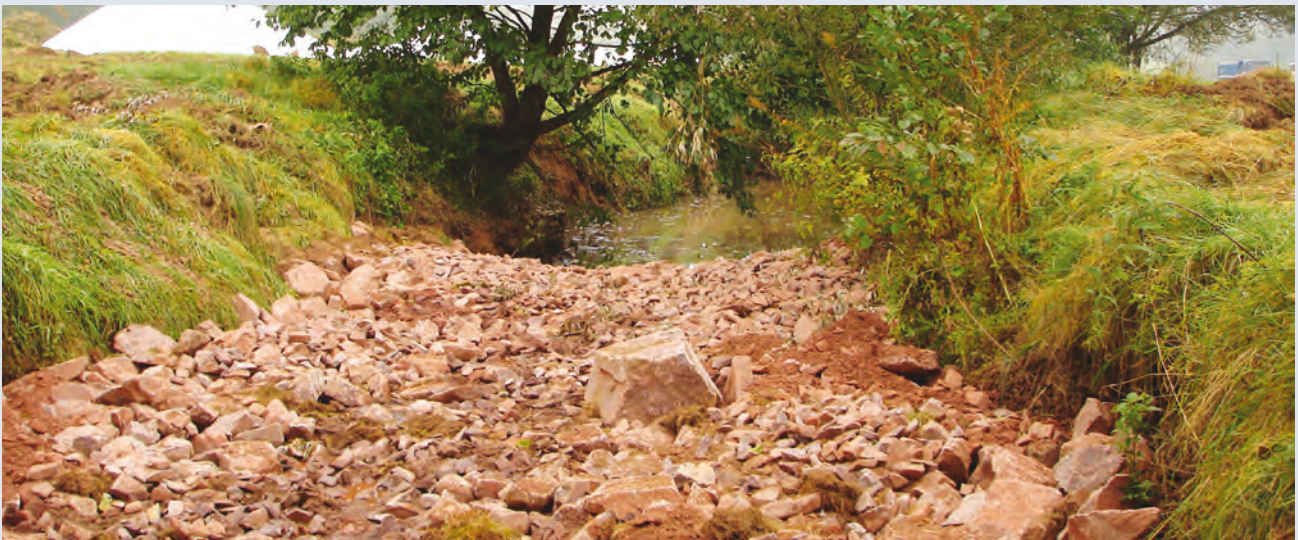
Sohlanhebung um rund 0,8-1 m – Bauphase im Sept. 2008
